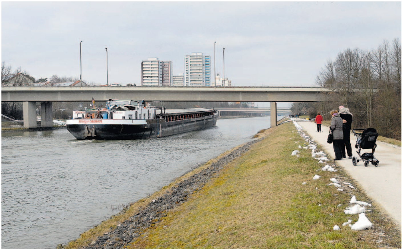
Die Brücke über den Main-Donau-Kanal im Zuge des Büchenbacher Damms muss dringend saniert werden: Dafür und für weitere Sanierungsarbeiten muss die Stadt viel Geld in die Hand nehmen.
